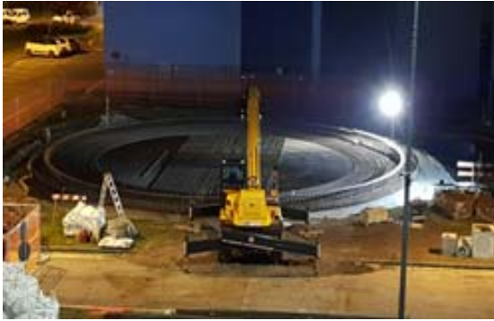
Brescia, c.le Lamarmora Fondazione nuovo accumulo calore da 6.000 m 3 in fase di costruzione
